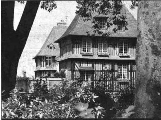
Deux tours XVIIe en colombages et tuileaux en arêtes de poisson
