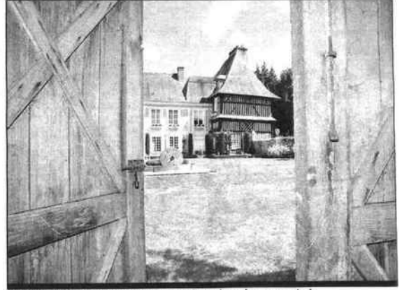
Vue du chai, un ancien pressoir trône dans le parc privé
